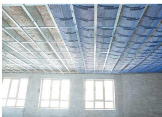
Isolation du plafond
